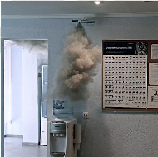
Пуск дыма при сработке охранной сигнализации
